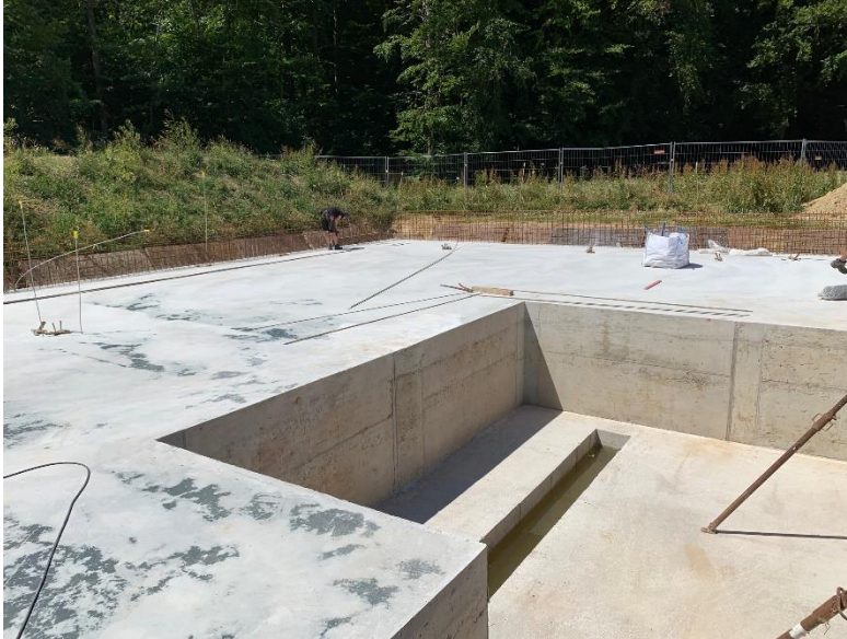
Abb. 2: Gründungsarbeiten mit Bodenplatte und Rohrkeller (Juni/Juli 2022)
